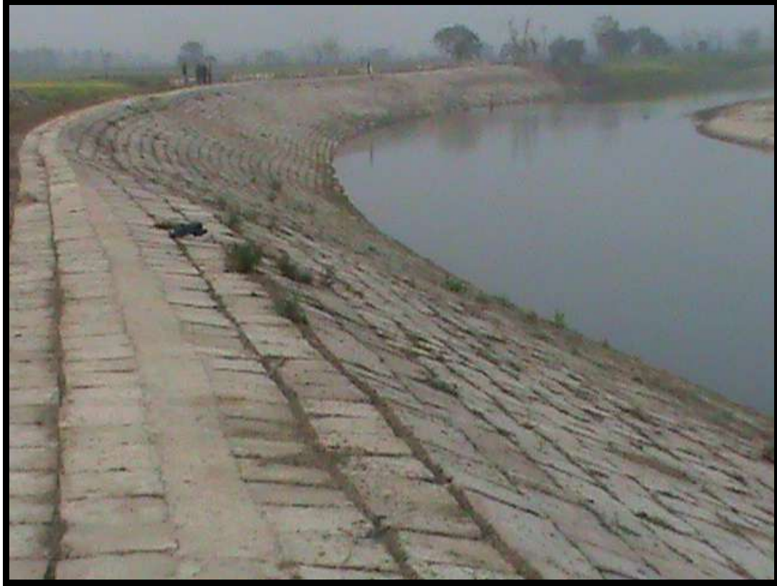
पश्चिम बंगाल में पुनरभावा नदी पर भारत बांग्लादेश सीमा पर तट-सुरक्षा कार्य का निर्माण Construction of bank protection works on river Punarbhaba on Indo-Bangladesh Border in West Bengal
